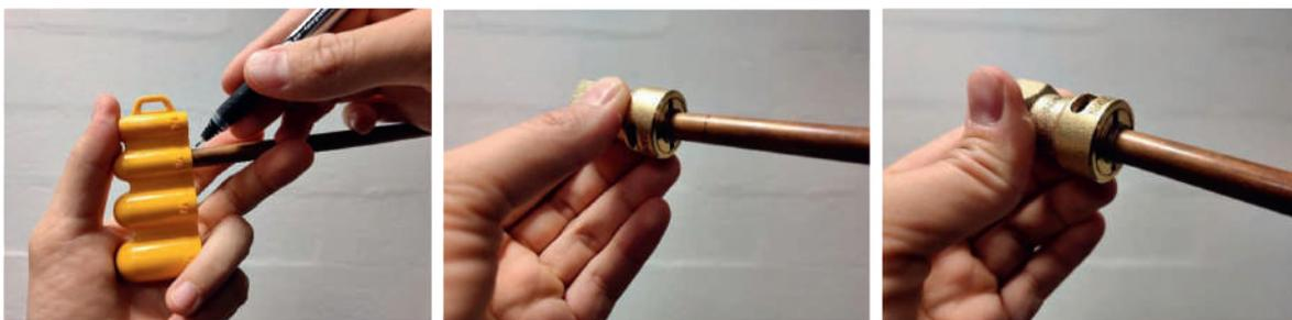
Utilisez le calibre pour marquer le cuivre (contrôle profondeur).
